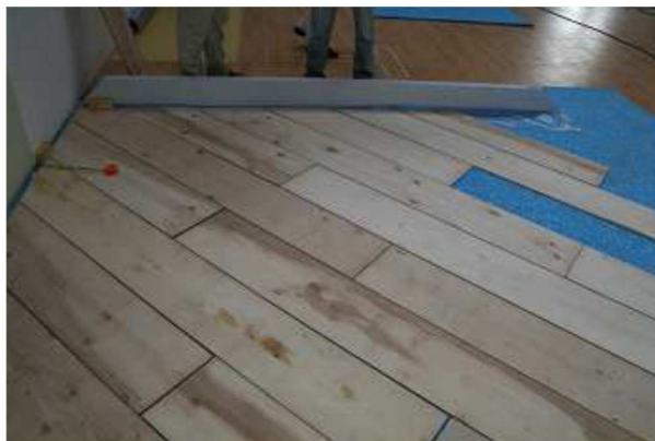
Īpašs ieteikums: vienmēr klājiet pilnu plāksni starp divām pusplāksnēm
