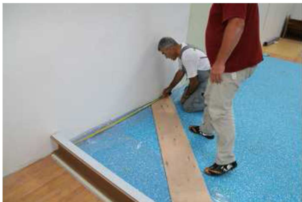
Pirmās Tarflex plāksnes uzstādīšana
